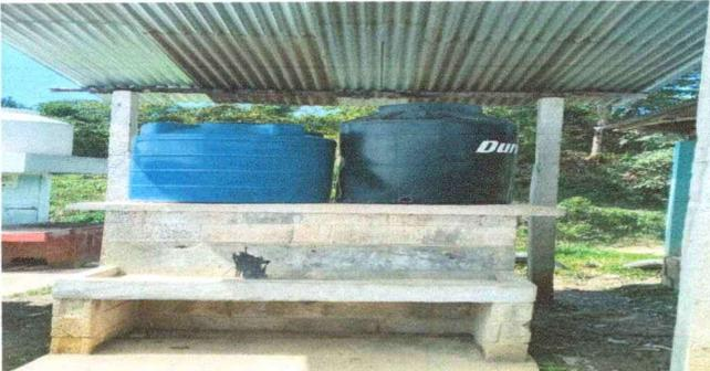
Foto 5: Se observa la falta de funcionamiento del depósito de agua por falta de accesorios
